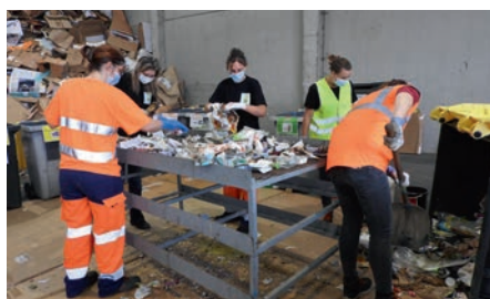
Tri de l'échantillon : les déchets sont déposés sur la table de tri et sont identifiés un à un pour être jetés dans le contenant adéquat
